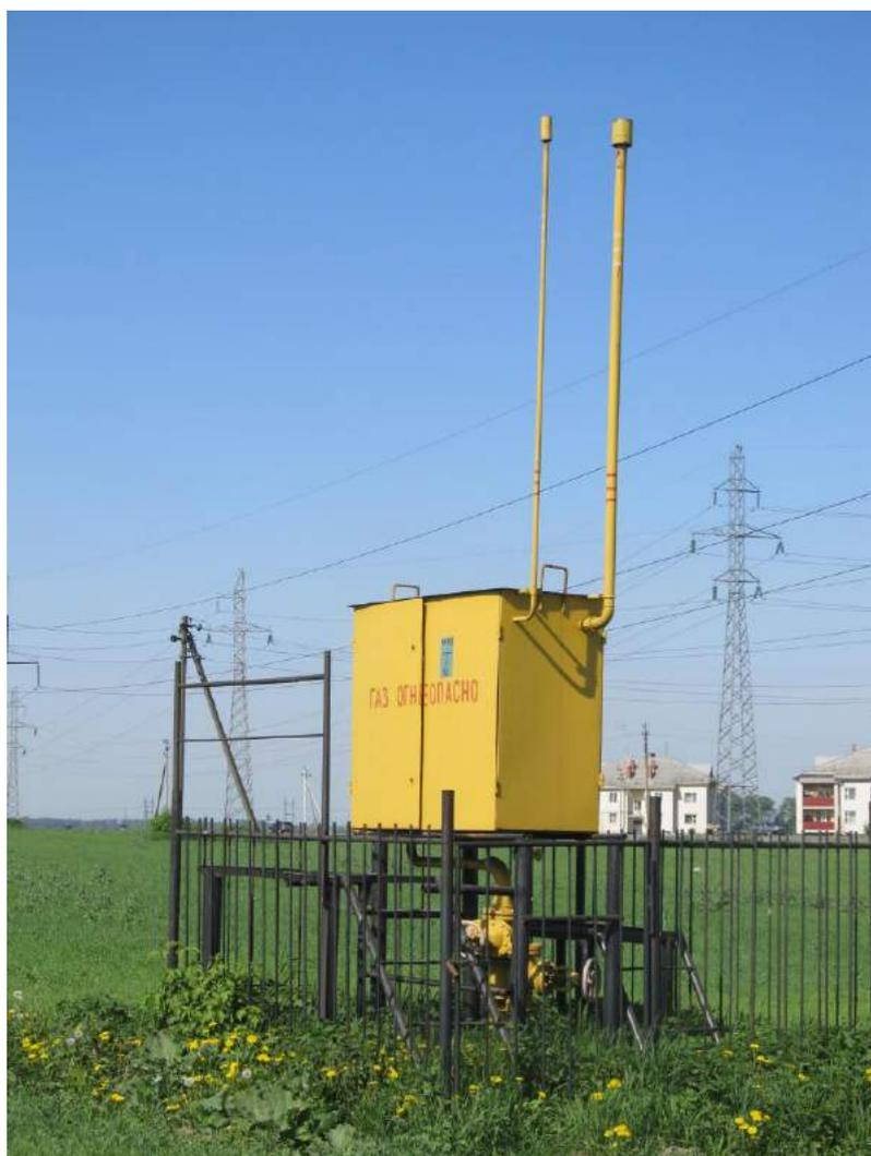
**Рисунок 13. Шкафной газорегуляторный пункт.**
